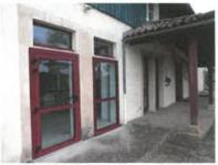
droite installer un châssis fixe également en aluminium. La couleur retenue pour ces menuiseries est le rouge basque, comme le reste de la salle des fêtes. Les deux châssis au-dessus des portes ont également été remplacés.
